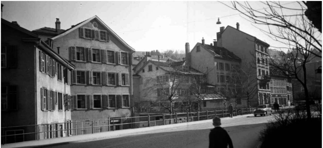
1960. Unteres Lämmli-brunn. Heute Baudepartments-Komplex.
